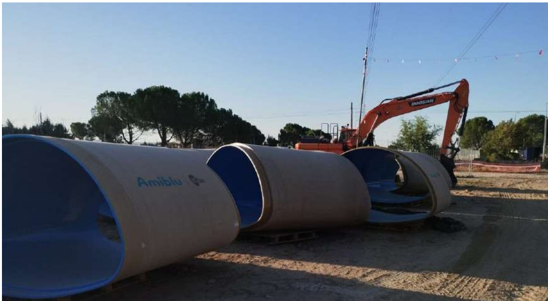
AMIBLU PIPES SPAIN participa proyecto renovación EDAR Fuente Saz Madrid
