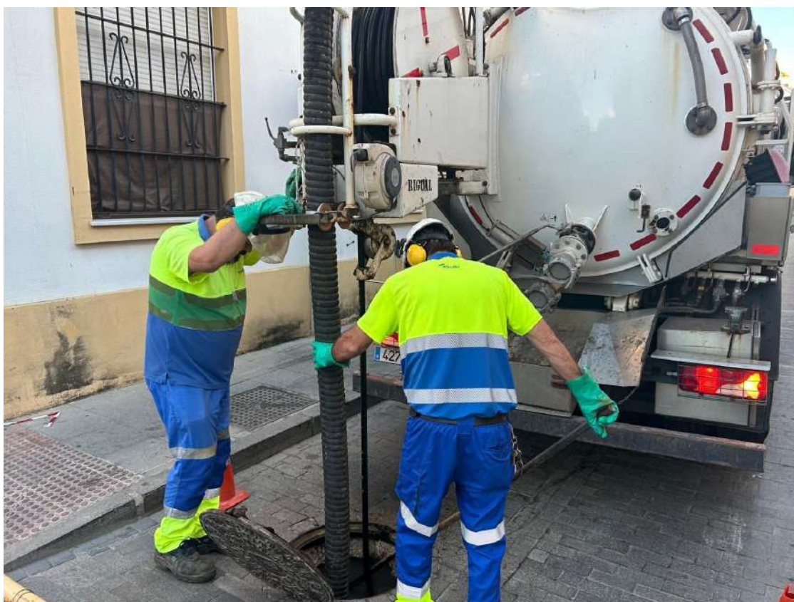
Trabajadores de Aqualia intervienen en las redes de saneamiento.
