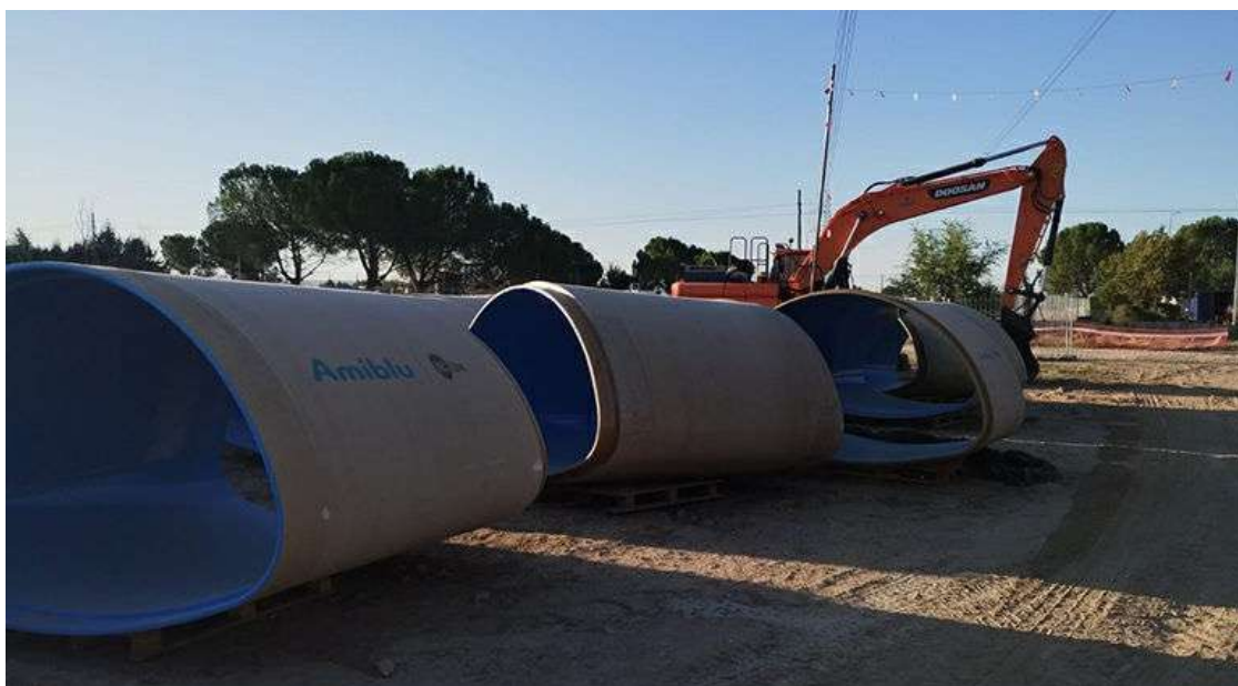
Amiblu Pipes Spain participa en el proyecto de renovación de la estación depuradora (EDAR) de Fuente el Saz de Madrid
